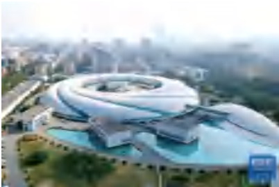
▲ 2月27日拍摄的位于上海张江科学城的“上海光源”（无人机照片）。
