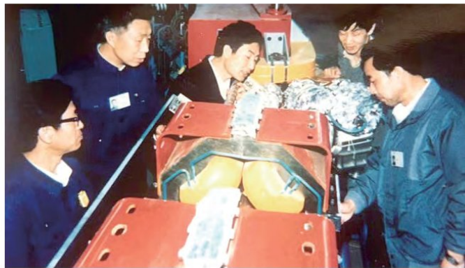
1999年，合肥光源一期工程，何多慧（左二）在现场检查储存环安装
